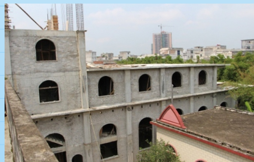
正在建築中的新教堂
